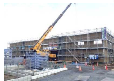
7月現在 花みずき白岡 建設中
